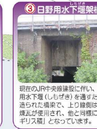
現在のJR中央線建設に伴い、日野用水下堰(しもぎさ)を通過するために造られた橋梁で、上り線側は日野煉瓦が使用され、他と同様に「イギリス橋」となっています。
