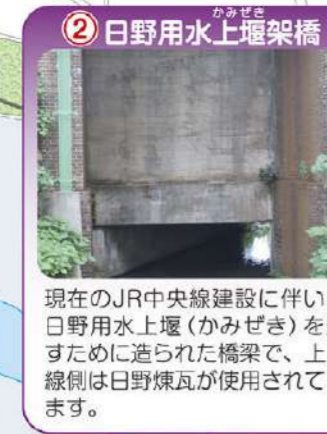
現在のJR中央線建設に伴い、日野用水上堰(かみぎさ)を通過するために造られた橋梁で、上り線側は日野煉瓦が使用されています。
