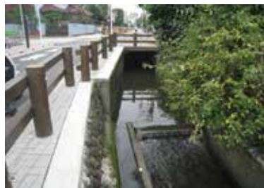
手すりが改修された日野用水上堰 (宿裏堀)
