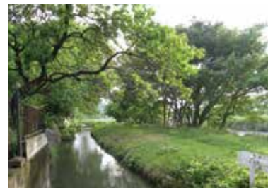
浅川内の導水堤
