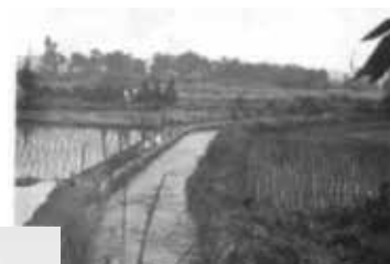
南平駅北側の南平用水路
