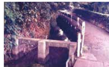
堀之内緑道沿いの豊田用水はここで分岐し緑道下を暗渠となって流れ浅川へと排水する。
