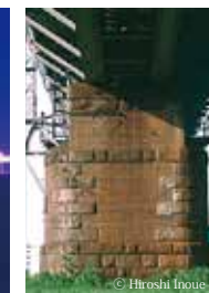
日野煉瓦の橋脚
