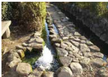
ポンプアップによる地下水の汲み上げ
