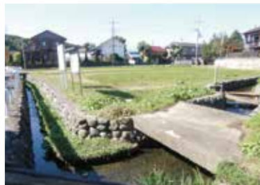
落川用水が一宮用水に合流するところ
