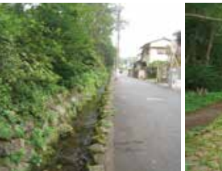
道路沿いの水路
